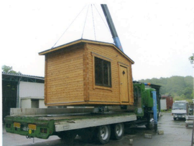
吊下げ状況（参考写真）
