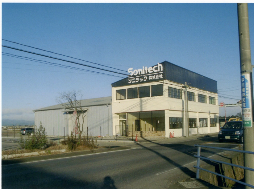
施工後 事務所
