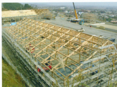
屋根軸組み状況
